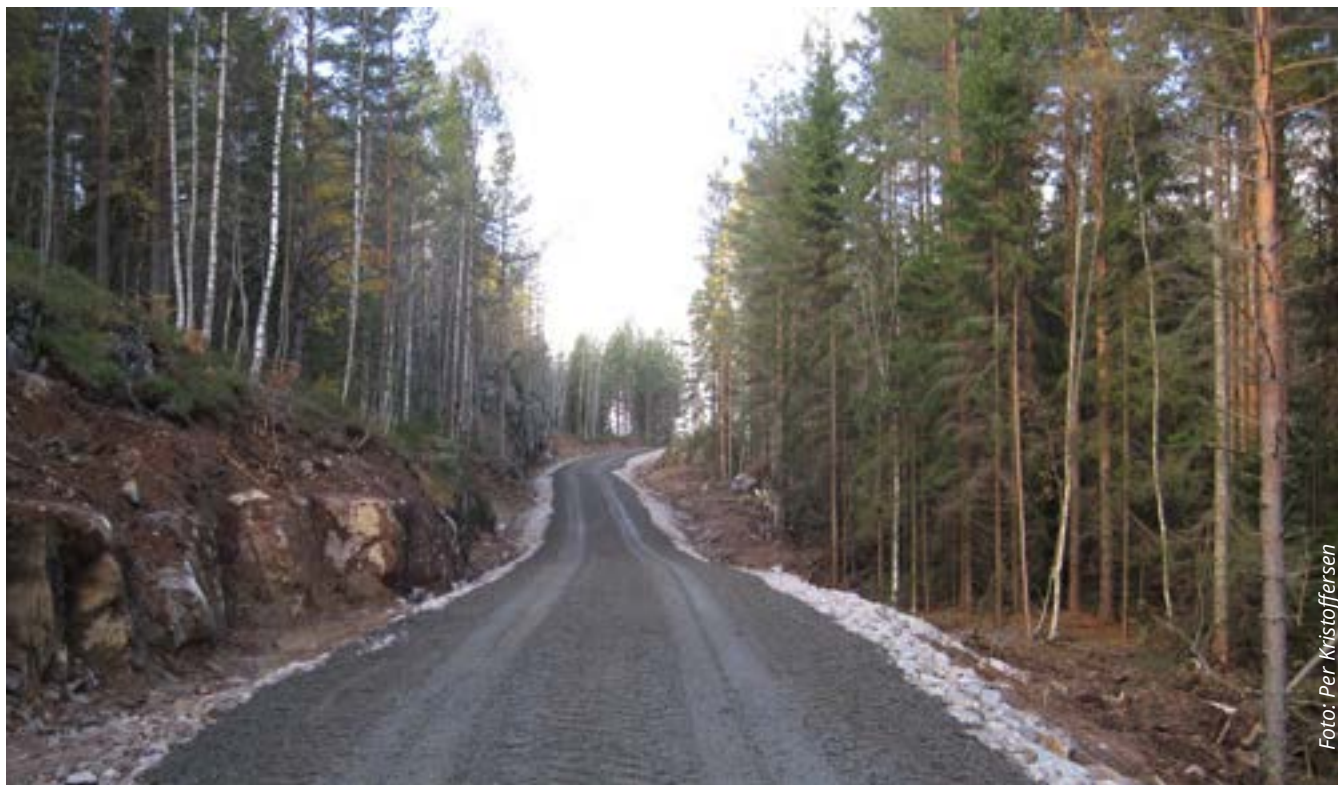
FIGUR 16 Telemark og Agder-fylkene var tidlig ute med å ta i bruk knust fjell som vegbyggingsmateriale
