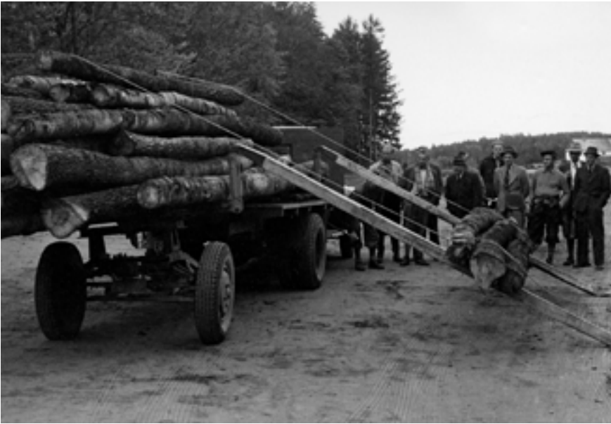
FIGUR 14 Lesseapparat, konstruert av Ludvik Isachsen (1881-1959) i Larvik. Vi ser en lastebil som er forlenget med en enkel tilhenger, en hjulgang med en overliggende tverrbanke og sidestenger. Tømmeret heises opp på lasteplanet og tilhengeren ved hjelp av vaiere som drar stokkene oppover på to stenger som er lagt på skrå fra lasset mot tømmerlunna ved vegkanten (til høyre for bildekanten). Foto: Maartmann, Knud [Geelmuyden Fleischer]/ ANNO Norsk Skogmuseum
